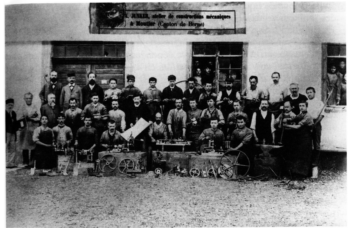
Fig. 6 Le personnel de la fabrique «Nicolas Junker» avec, au premier plan, un tour automatique à poupée mobile, système Schweizer. La photo date vraisemblablement des années 1890.
